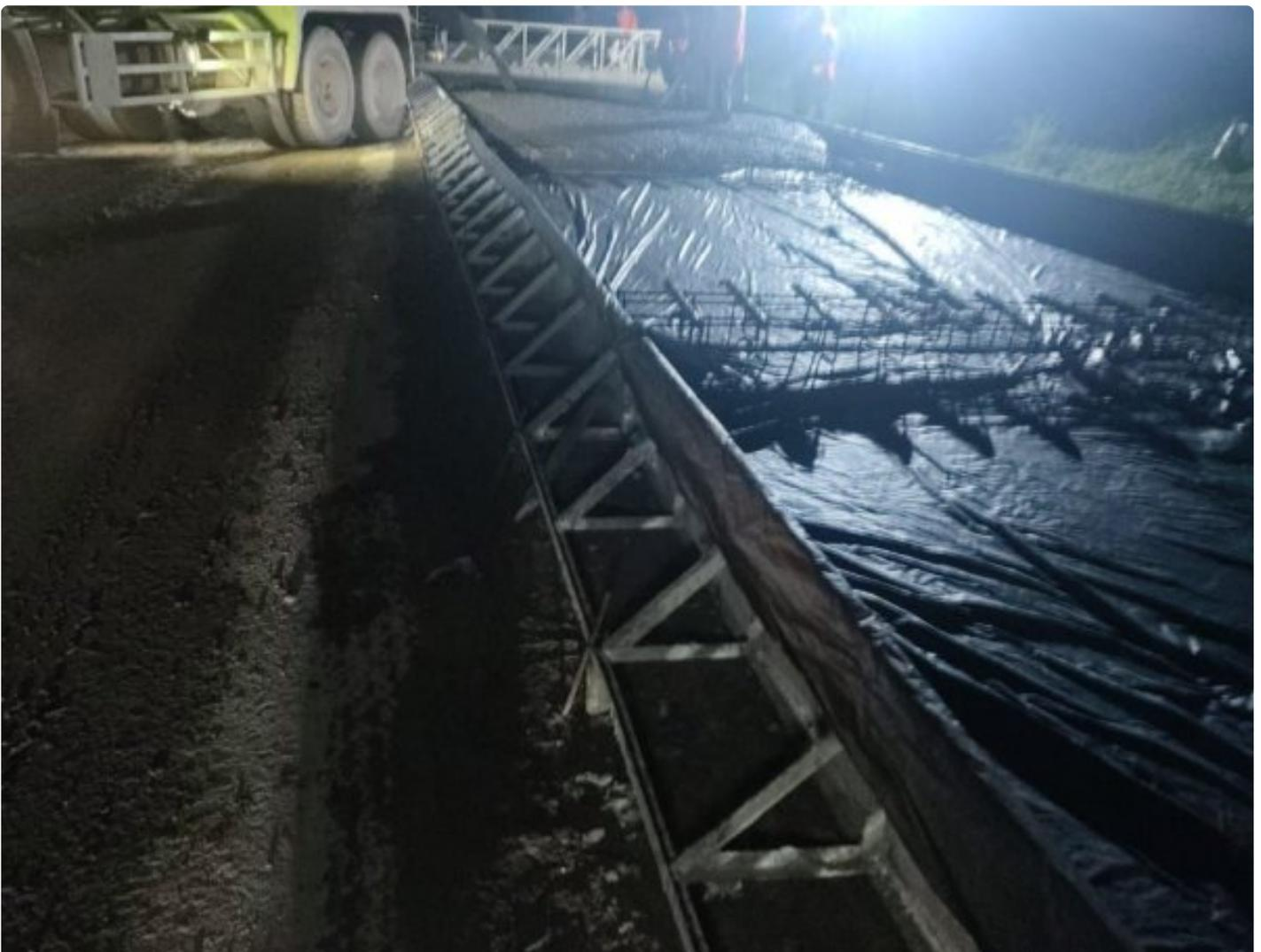
**JAMBI** - Wiremesh (tulangan rangka baja) sering digunakan dalam konstruksi beton dengan cara dipasang atau digelar kemudian adukan beton bisa dituang di atas wiremesh lalu diratakan. cor menggunakan wiremesh lebih kokoh karena memiliki daya tarik yang lebih tinggi dan juga bisa membantu menstabilkan beton agar tidak mudah rapuh.
